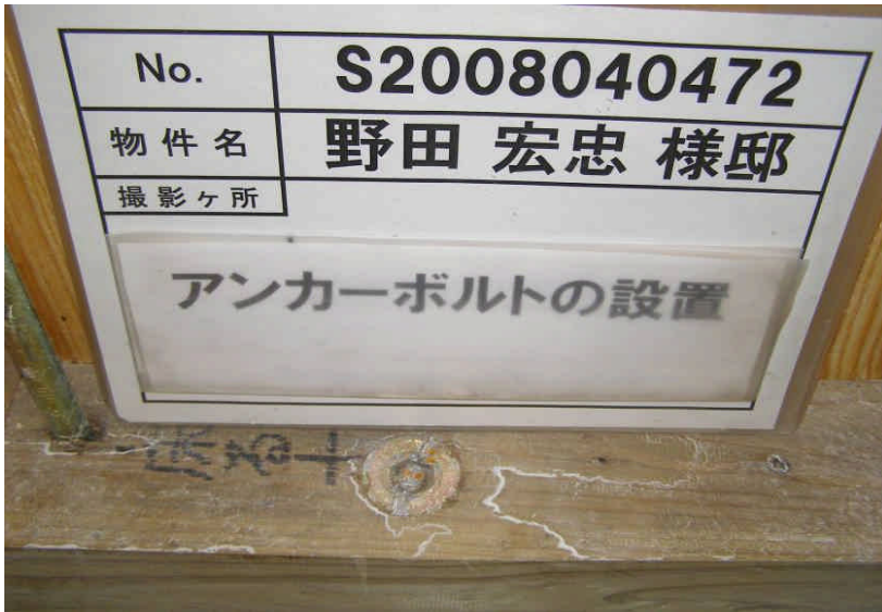
アンカーボルトの設置
